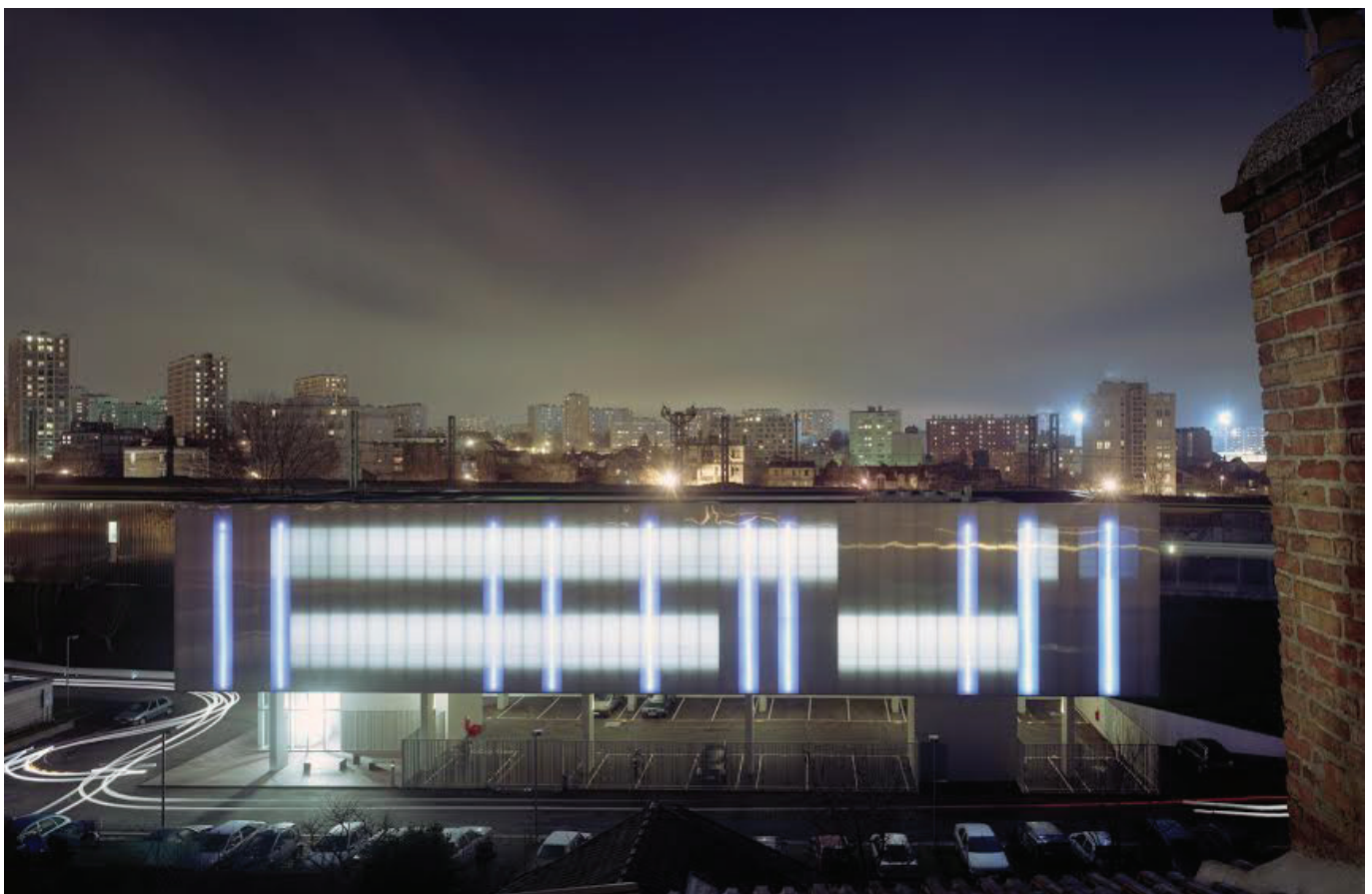
Malakoff (92), Poste de Commandes Centralisées de la ligne 13 pour RATP/SEDP, livraison 2006, photo : DR
