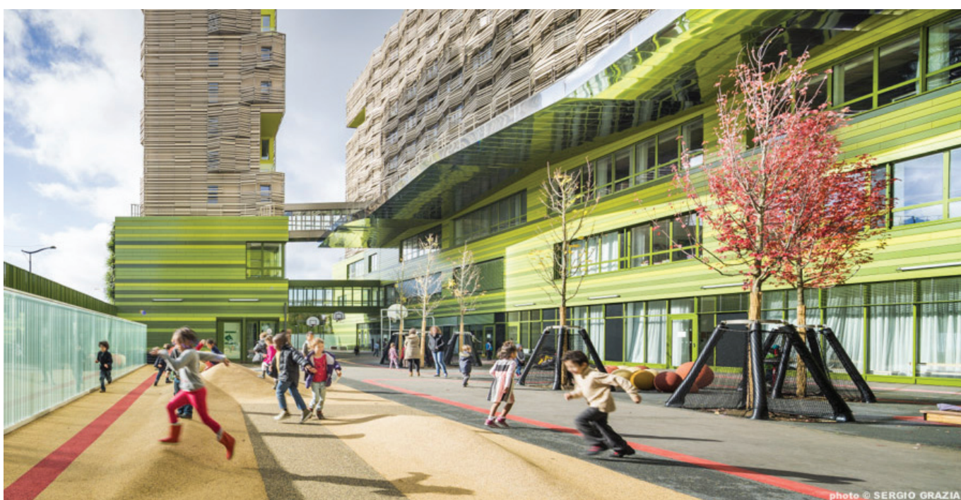
Paris (17e), résidence étudiante 152 lgts + 1 lgt de gardien, cuisine centrale 1250 repas/jour, école polyvalente 12 classes, centre de loisirs + 2 lgts de gardien
